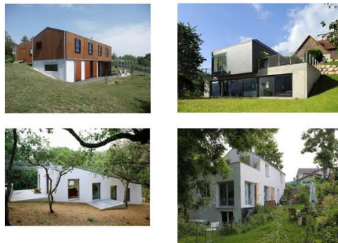
Quelques exemples de constructions favorablement implantées dans la pente.
