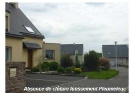
Absence de clôture lotissement Pleumeteuc
